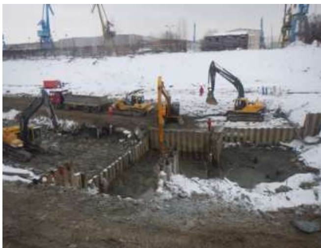
FOTO 15 -demolare fundații structură FerryBoat
