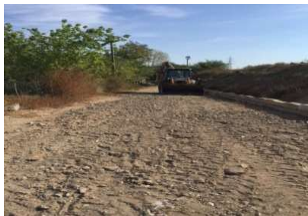
FOTO 101 - Reabilitare strada de pământ prin scarificare, nivelare și la baza rambleului precum și așternere de beton
