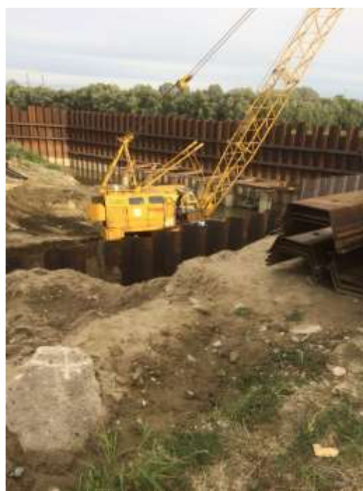
FOTO 5 - -lucrări de demolare a construcțiilor existente 2017
