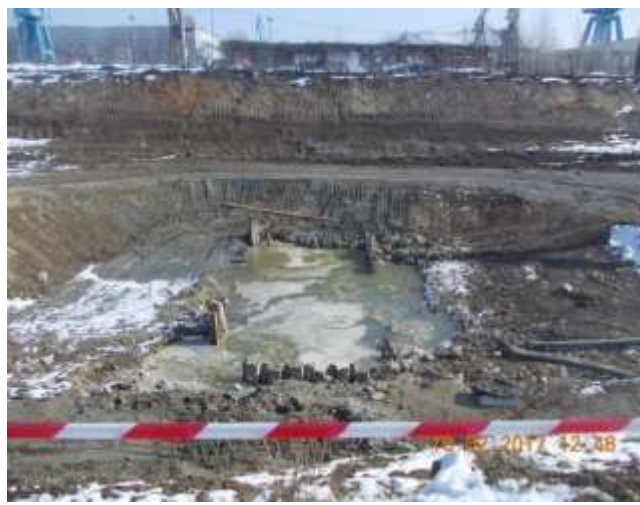
FOTO 15 -demolare fundații structură FerryBoat
